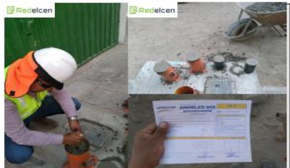
FOTO Descripción: Preparación de probetas del concreto pre-mezclado
