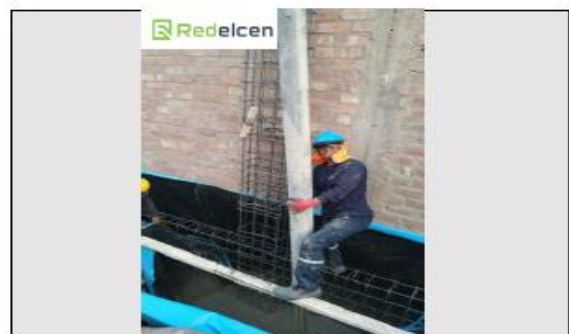
FOTO Descripción: Baseado de Concreto pre-mezclado en zapatas
