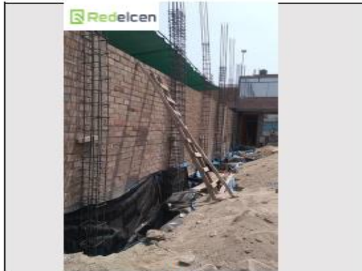
FOTO Descripción: Instalación de columnas perimetrales
